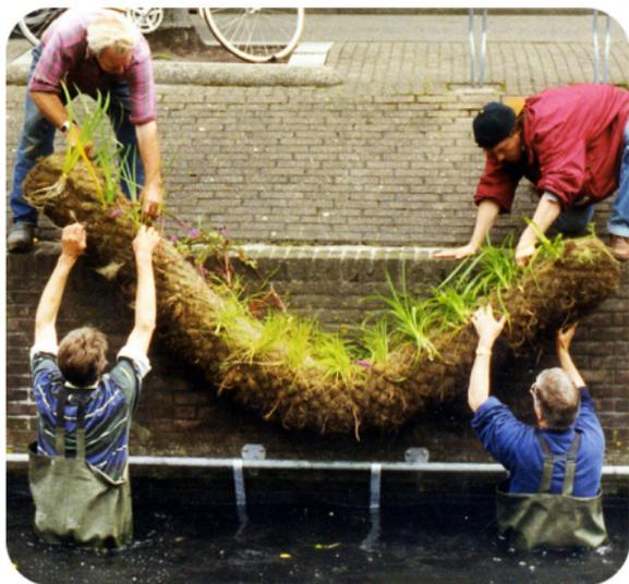
Pour la stabilisation et l'embellissement des rives, la fascine 100% recyclable est proposée en 6 configurations d'espèces végétales selon usage (épuration des eaux, résistance au piétinement ou au brouillage, soutènement, site ensoleillé ou non, etc.). Possibilité de pose combinée sur palplanches, gabions et autres solutions minérales. Dimensions fascines
