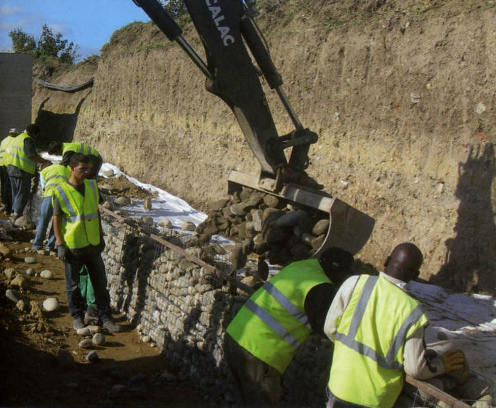
Les cellules des gabions électrosoudés sont remplies sur place avec des galets de la Garonne.
