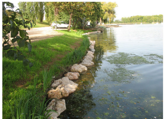
Fascines coco pré-végétalisées d'hélophytes en pied de berge derrière des piquets en bois ou des enrochements.
