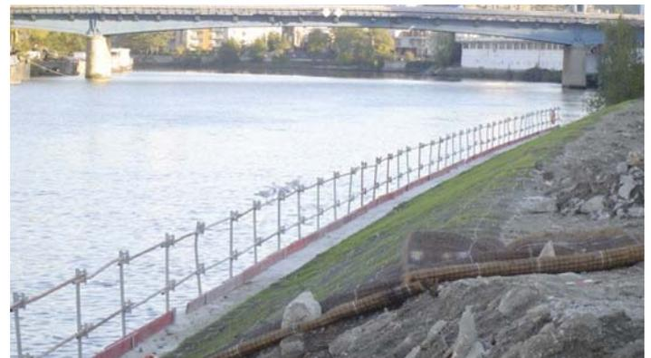
Les points de couleurs (DOT System) sur le tapis anti-érosif indiquent l'emplacement des cavaliers de fixation, d'où gain de temps et qualité de la fixation. Cette géogrille ne nécessite pas de couverture de terre. Elle est immédiatement efficace. Le remplissage de fibres de coco améliore grandement la levée des semences, les protégeant de la dessiccation, du vent, des oiseaux et du choc thermique jour/nuit.
