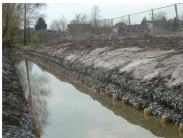
Figure 1 : Confortement du pied de berge par Rock Rolls
