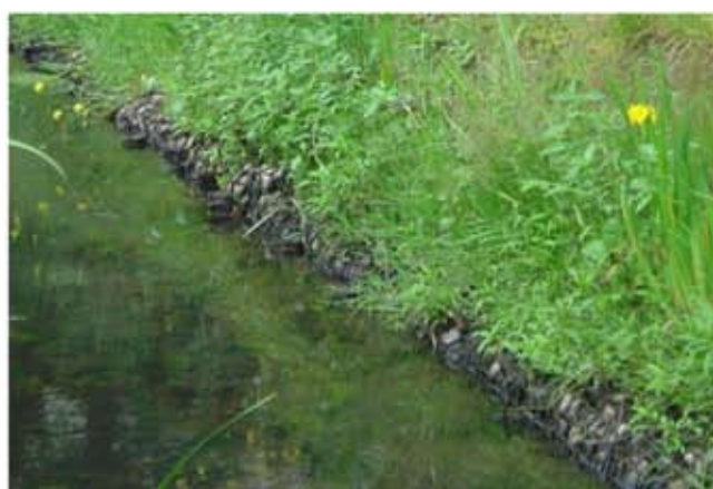
Figure 2 : Végétalisation d'une berge confortée avec des Rock rolls
