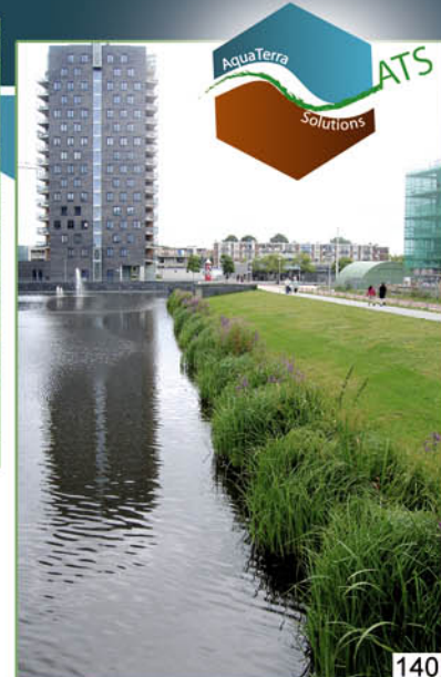
138 à 140. Végétalisation d'un canal par fascines d'hélophytes.
