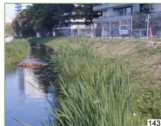
141 à 143. Munich : Végétalisation et protection de berges avec des géonattes pré-végétalisées.
