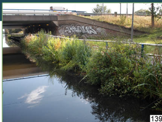
138 à 140. Végétalisation d'un canal par fascines d'hélophytes.
