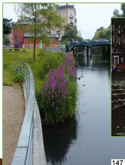
147 à 149 : Végétalisation par géonattes pré-végétalisées de pieds de perrés. Malgré le reflux des vagues dû au passage des bateaux, la végétation s'installe bien.
